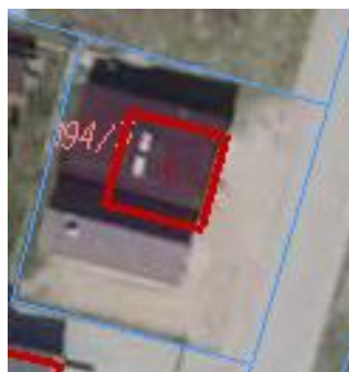
Rys. 4. Budynek na potrzeby OSP w Łapach-Dębowinie, 18-100 Łapy, działka 194/3 (panel 12kWp montowany na dachu)
