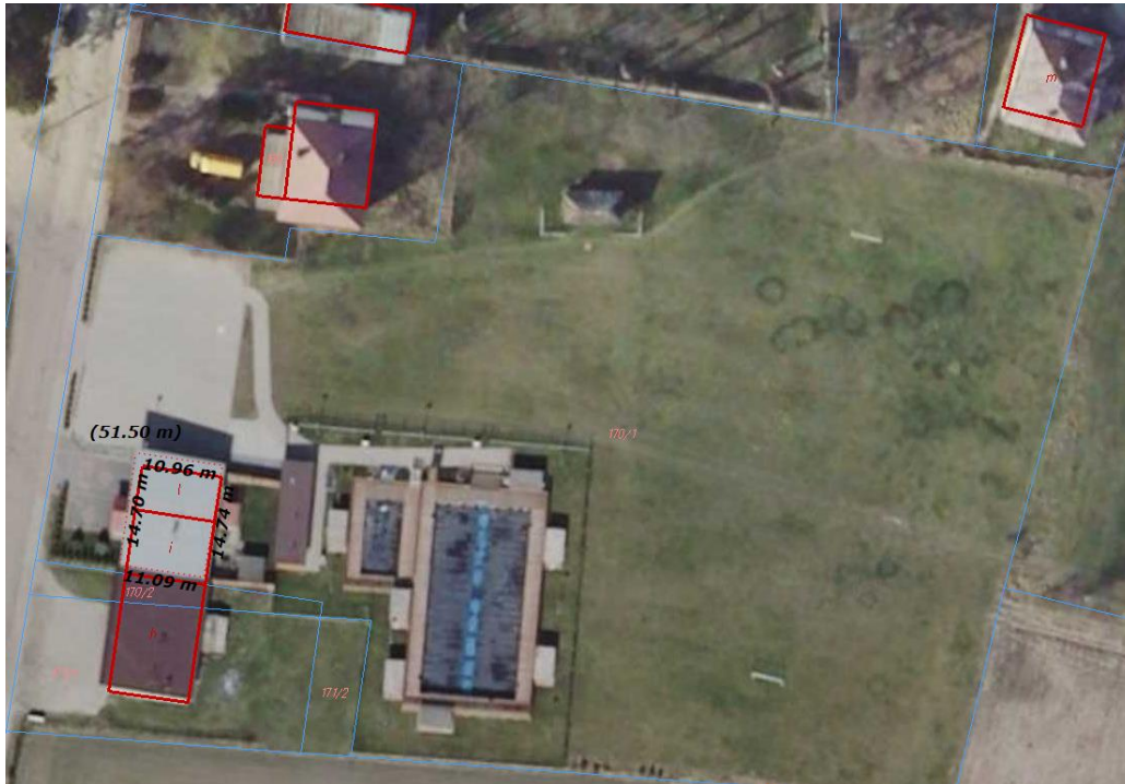
Rys. 5. Budynek na potrzeby OSP w Płonce Kościelnej, Płonka Kościelna 99, 18-100 Łapy, działka nr 170/1, zestaw 8kWp montowany na dachu na potrzeby budynku OSP + zestaw 42kWp montowany na gruncie na potrzeby basenów)
