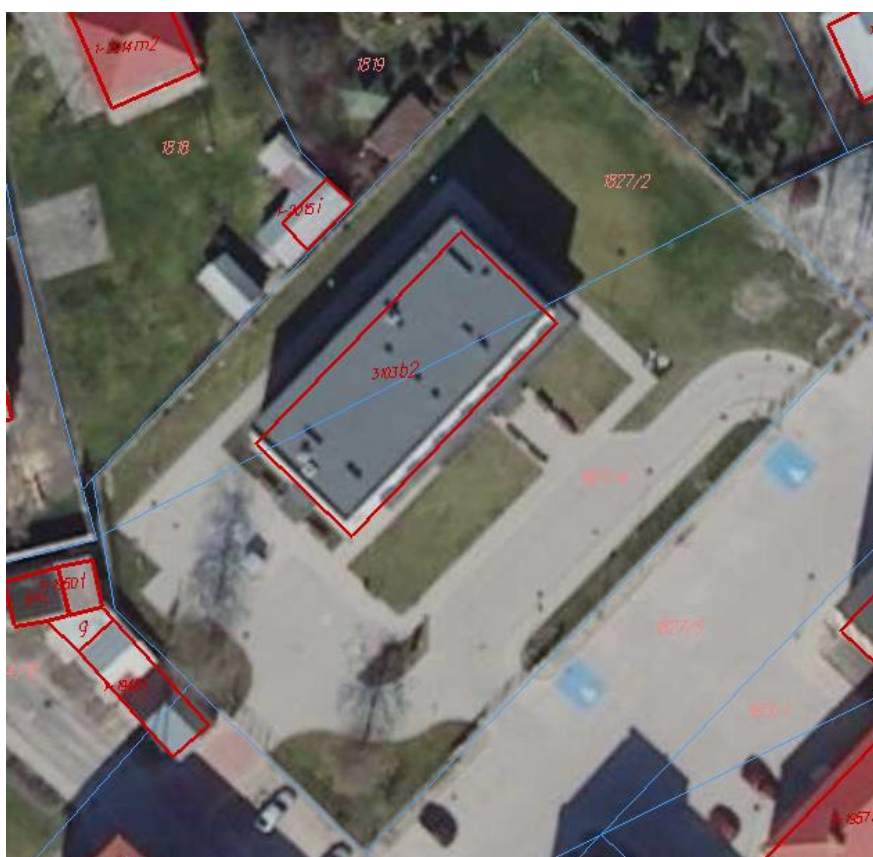
Rys. 13. Inkubator Przedsiębiorczości w Łapach, ul. Gen. Wł. Sikorskiego 22a, 18-100 Łapy, działka 1827/2, 1827/4 (panel 40kWp montowany na dachu)
