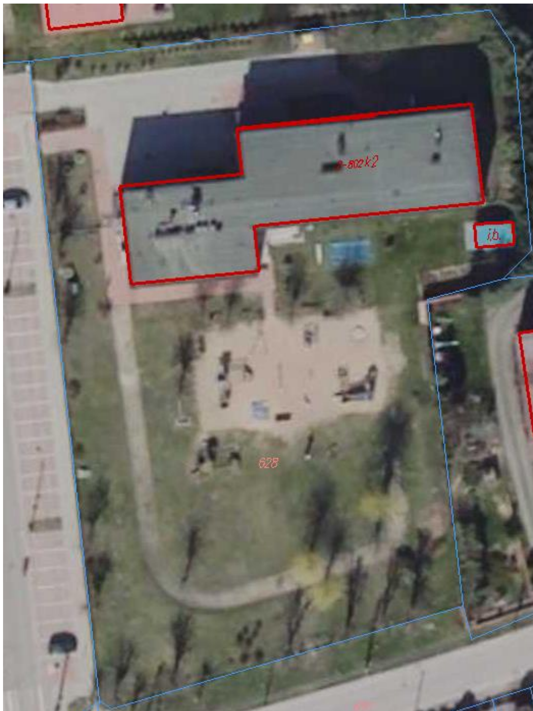
Rys. 11. Przedszkole nr 2 w Łapach, ul. Cmentarna 23, 18 – 100 Łapy, działka nr 628 (panel 18kWp montowany na dachu)
